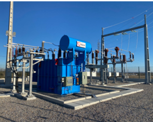
Umwandlung auf höhere Spannungsebene zum Transport des Stroms
