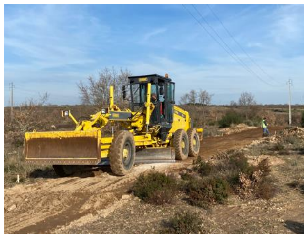
Bau der Zugangsstrasse für die Anlage Mogadouro
