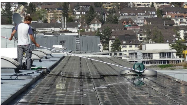
Reinigung einer PV-Anlage
