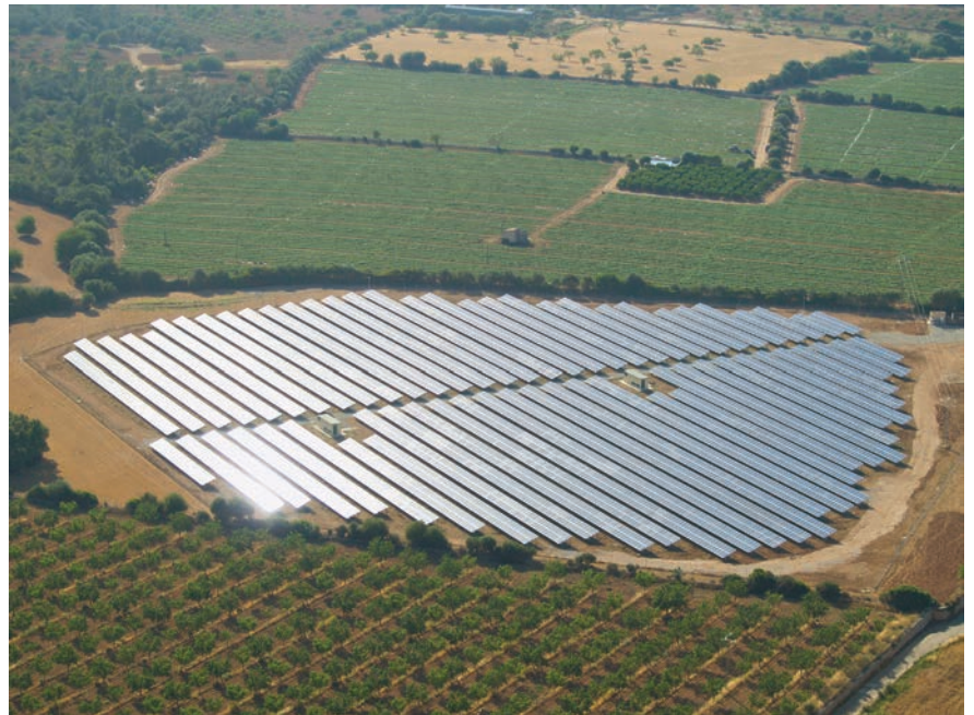
Die Anlage Cortadeta liefert Strom für rund 670 Haushalte.
