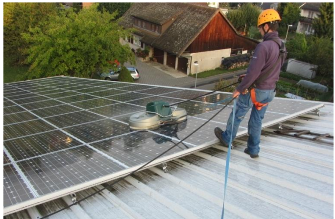
Nettoyage professionnel des modules (photo: BE Netz AG)
