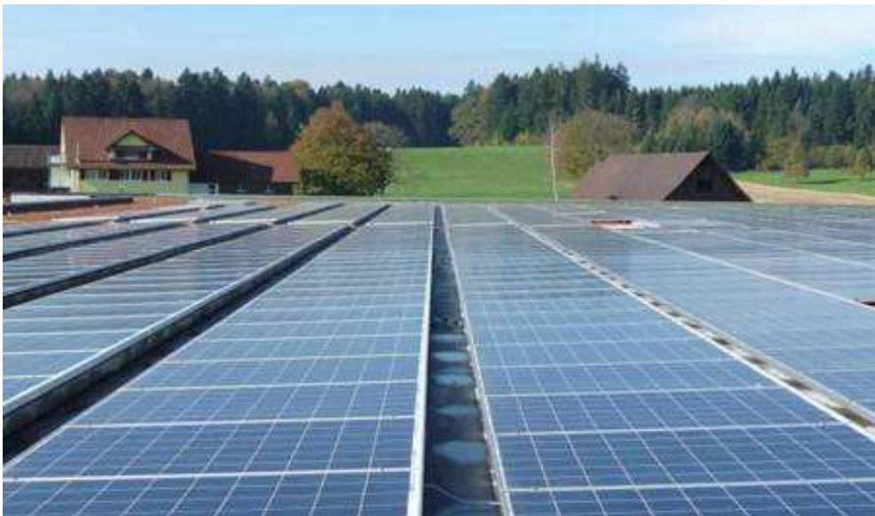
Vue partielle sur le toit plat du nouveau centre de transbordement de marchandises. La très faible inclinaison des modules solaires permet une utilisation maximale de la surface du toit.
