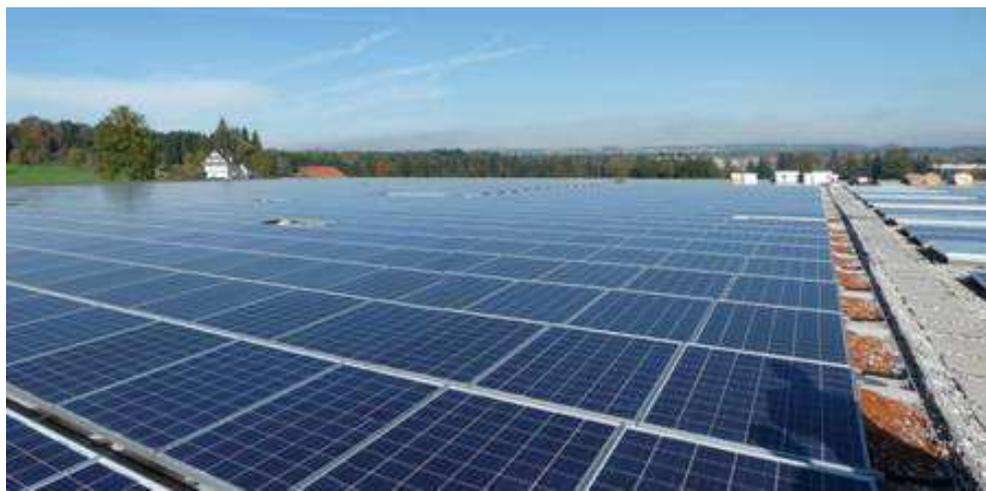
Vue sur l'installation posée sur le toit plat du nouveau centre de transbordement de marchandises. En raison d'une hauteur de construction maximale autorisée à ne pas dépasser, les modules ont dû être installés presque à plat.
