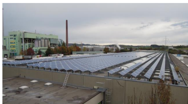
Älteste deutsche PV-Anlage der Edisun Power: Lebert Kempten
