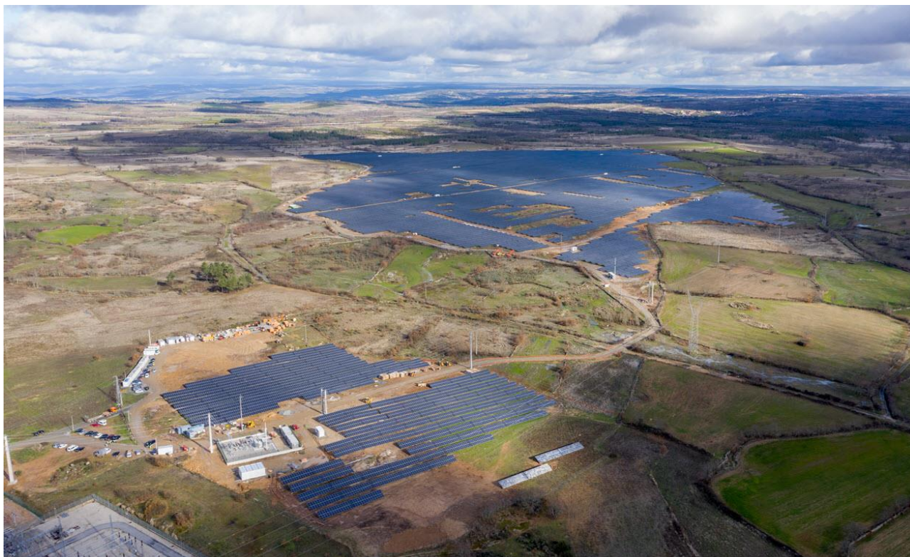
PV-Grossanlage Mogadouro mit Platz für Batterie oder Elektrolyseur
