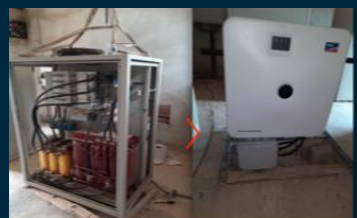
Digrun Wechselrichterersatz
